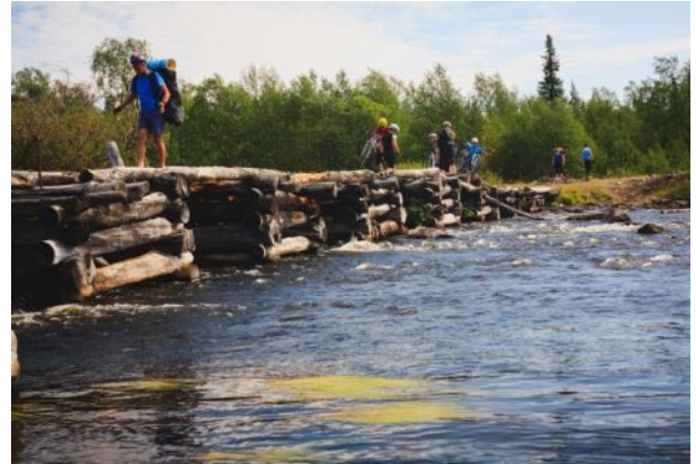
Разрушенный мост через р. Сура
